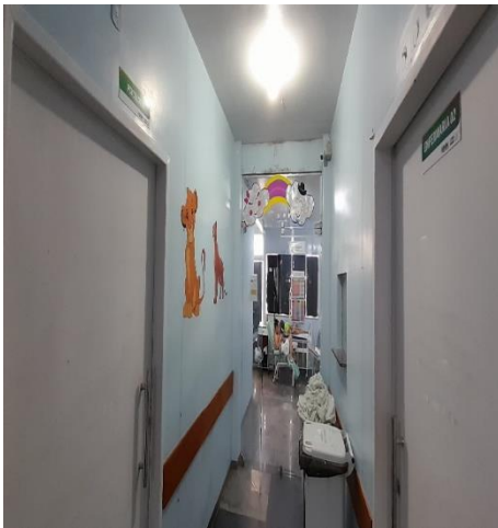
Figuras 3 e 4: Leitos que estão sendo reformados.
