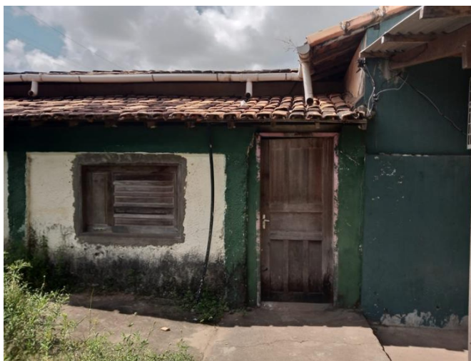
Figura 1 – Faixada da biblioteca
