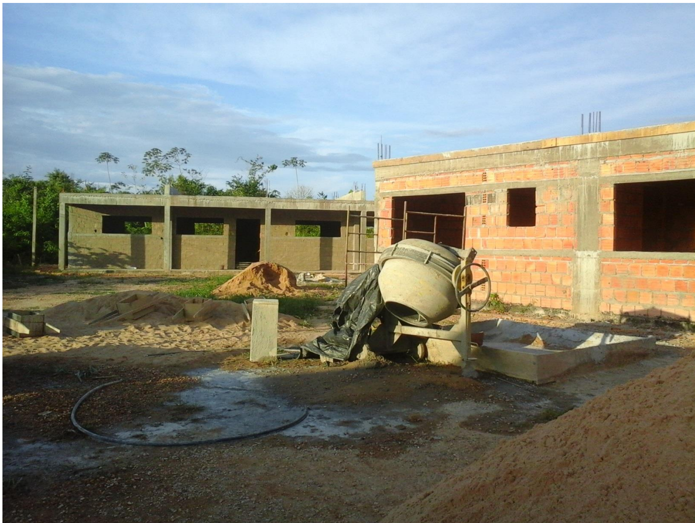
Anexo II: Foto da futuras instalações Escola Carlos Marighella. (Foto autora)
