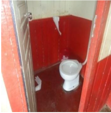
Figura 8 banheiro da escola
